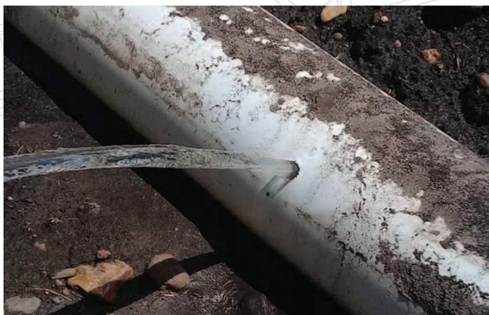
Aducción de agua desde mangas sin compuertas a los surcos
