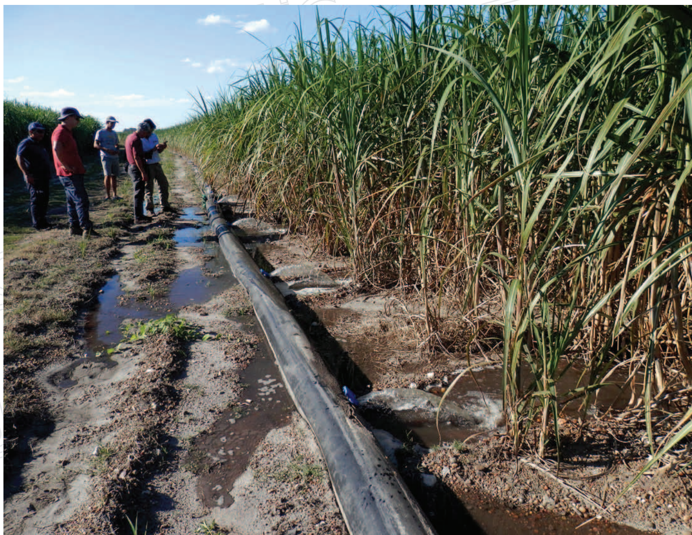
Distribución y aducción de agua a surcos con la utilización de mangas con compuertas.
