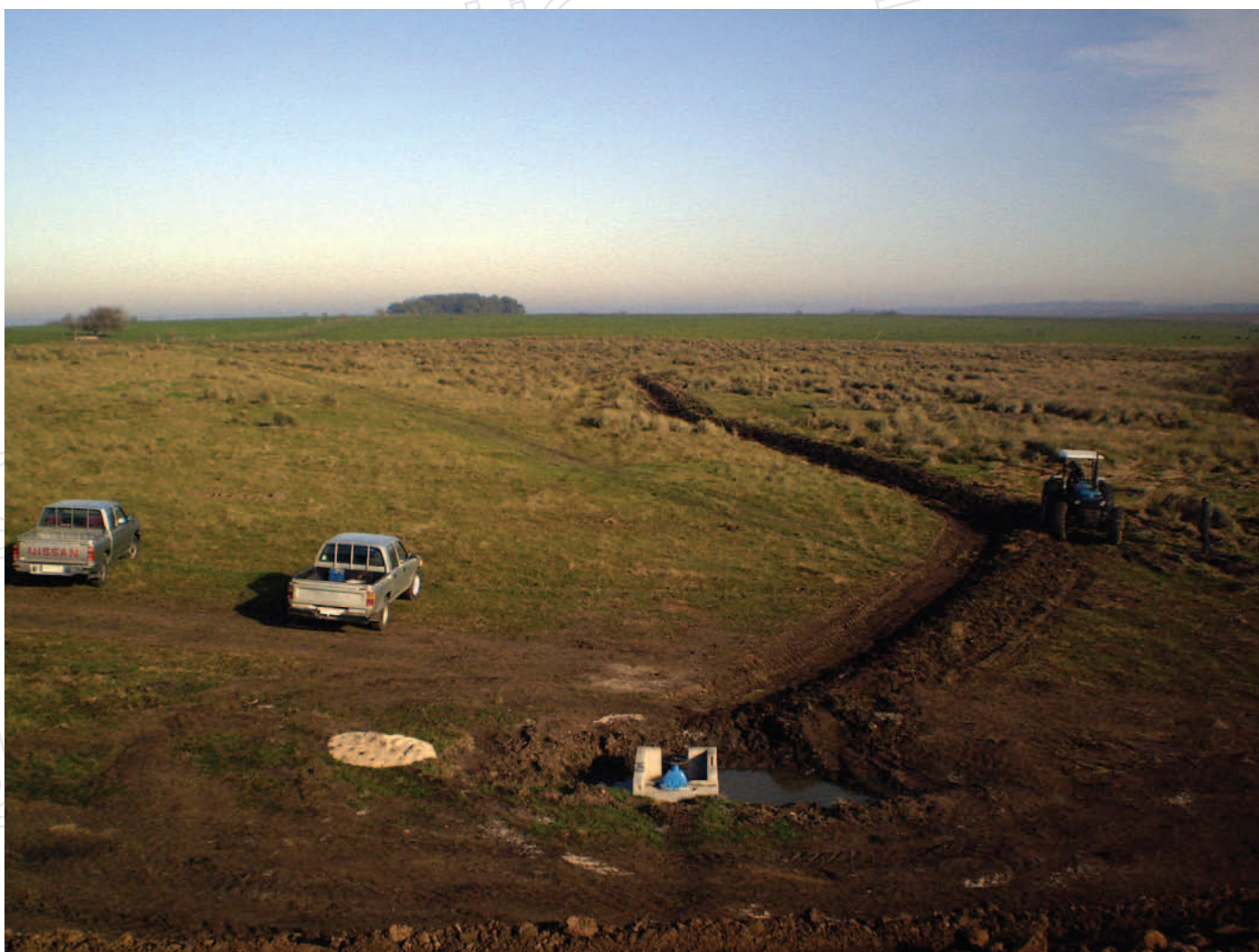
Inicio del canal de riego o terraza de canal de la estructura que se muestra en la Figura 1 con un ancho de fondo b = 1,0 metro y gradiente de pendiente de 0,001 m/m..
